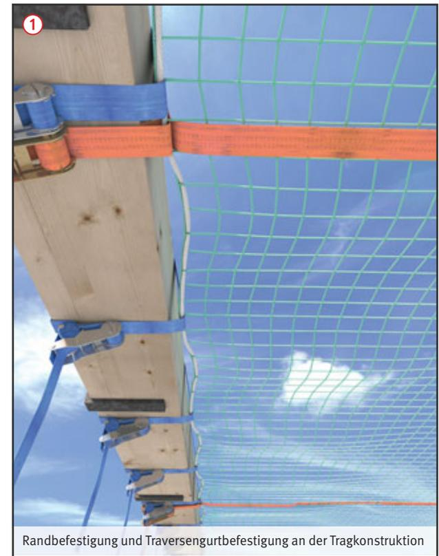
Randbefestigung und Traversengurtbefestigung an der Tragkonstruktion
